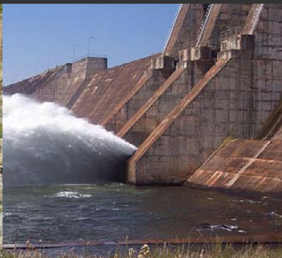
Planta Hidroeléctrica Chixoy/INDE. Represa Hidroeléctrica del Yguasu / FFMM
